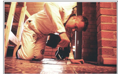
Mikael Roming demonterar skyddslistor inför golvdemontering
